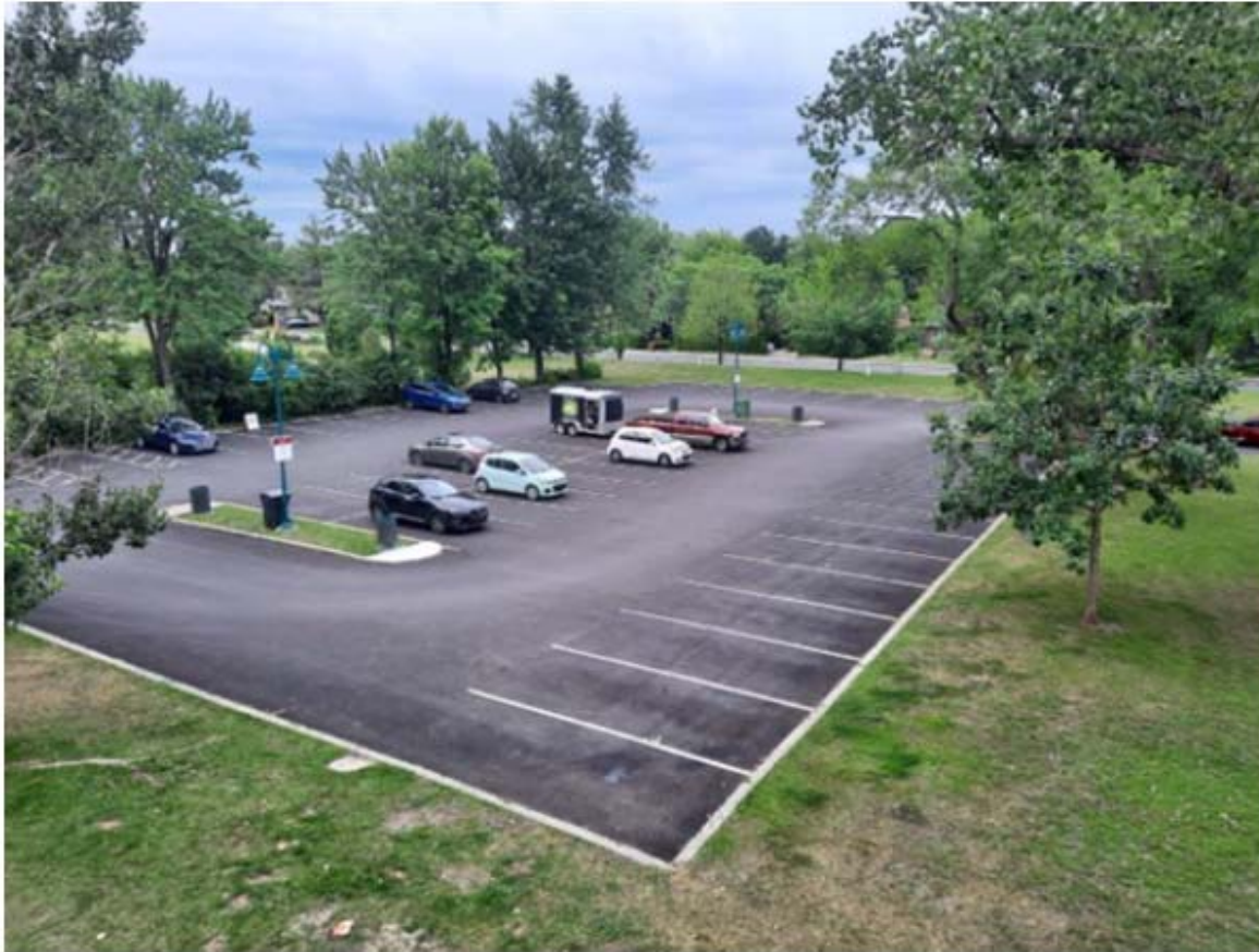
Resurfaçage du stationnement au parc André-J.-Côté
