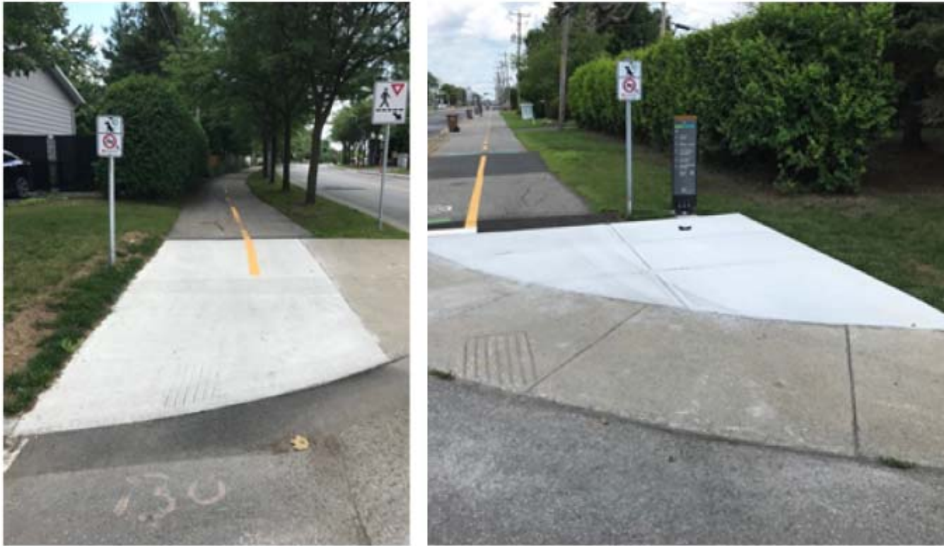
Réfection des dalles de repos en béton de la piste cyclable SFX
