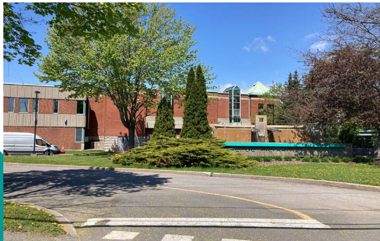
Agrandissement de l'usine de filtration
