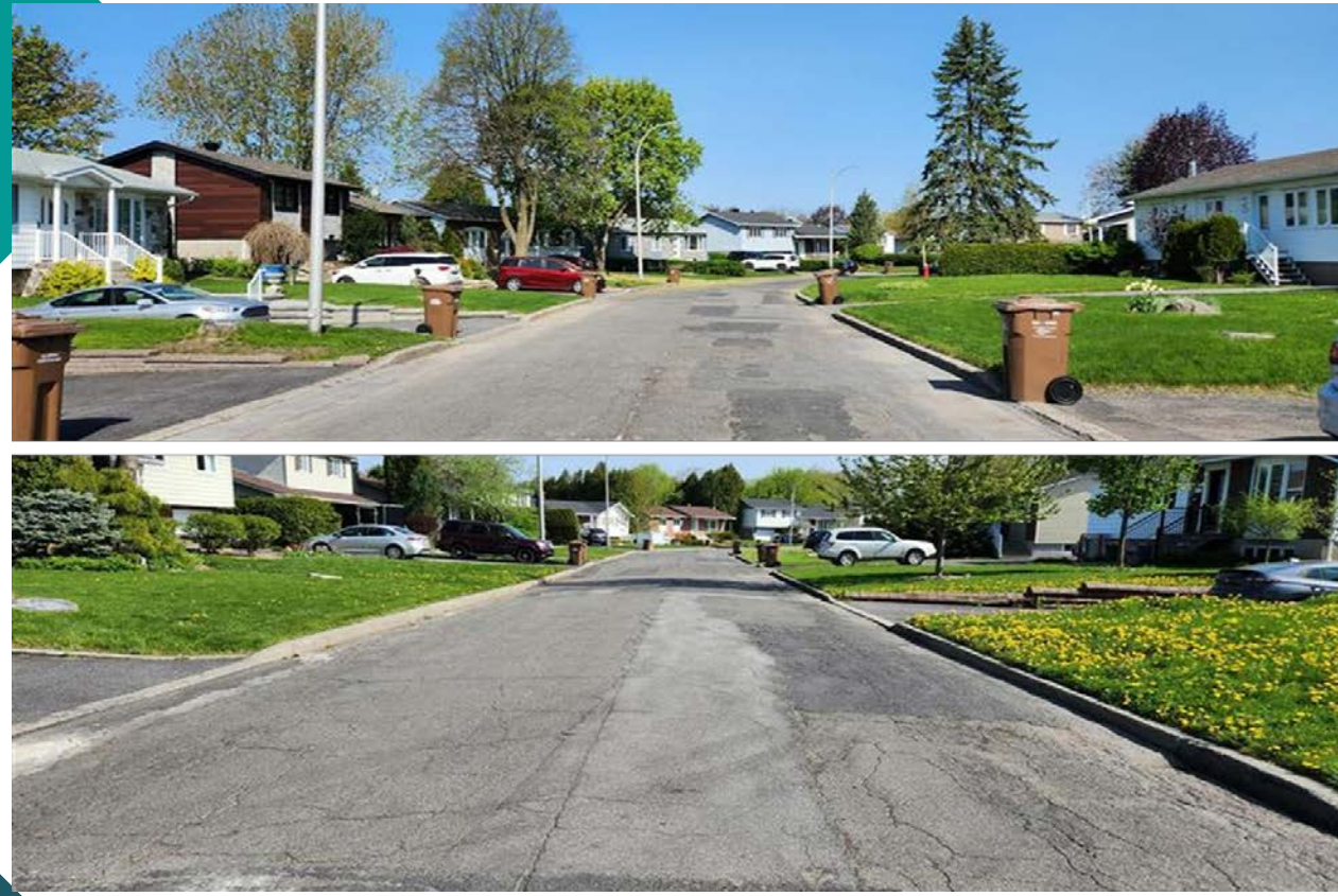
Travaux de refection – rue Gênes
