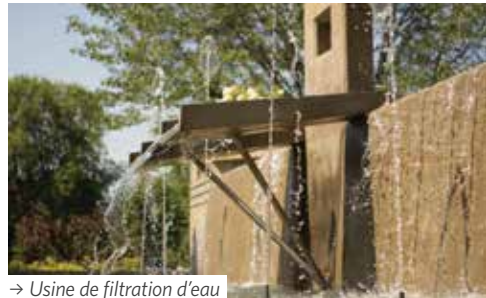
→ Usine de filtration d'eau
